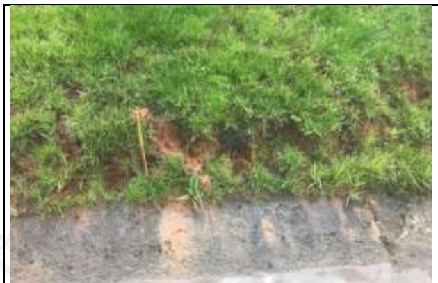
Foto 14 - Ponto de saída de um dos DHPs danificado por pisoteamento de animais.
