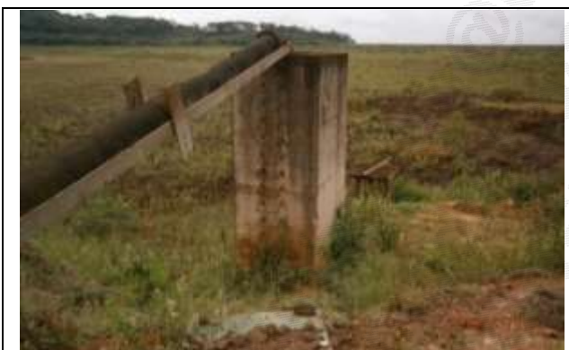
Foto 9 - Torres de tomada d'água do sistema extravasor, sem anomalias. Classificação quanto EC ("confiabilidade das estruturas extravasoras"): 0.
