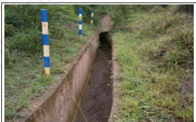
Foto 10 – Desemboque do primeiro trecho da galeria de fundo do sistema extravasor e canal a céu aberto, sem anomalias.
