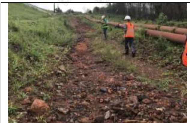
Foto 17 - Acesso na região do pé da barragem, pela ombreira direita, com erosões.
