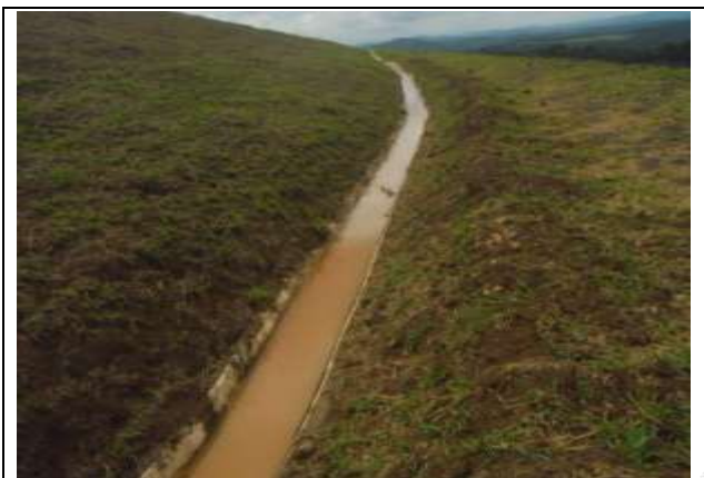
Foto 7 – Canaleta de drenagem superficial com empocamento de água, devido à deficiente na inclinação das mesmas.
