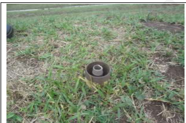
Foto 15 - Instrumento INA 05 sem tampa de proteção.
