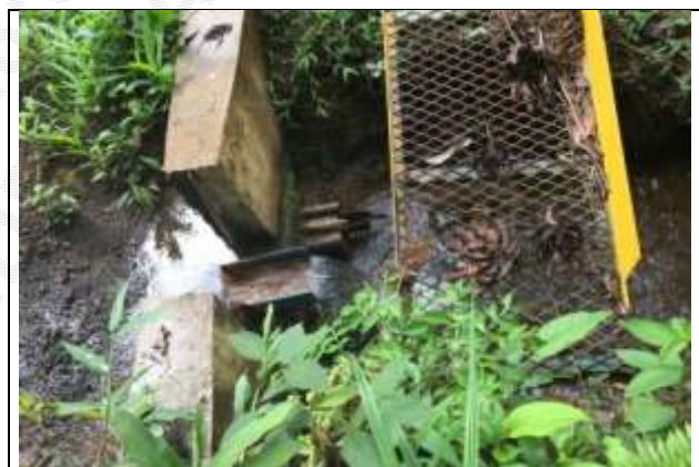
Foto 16 - Medidor de vazão do dreno de fundo, operante.
