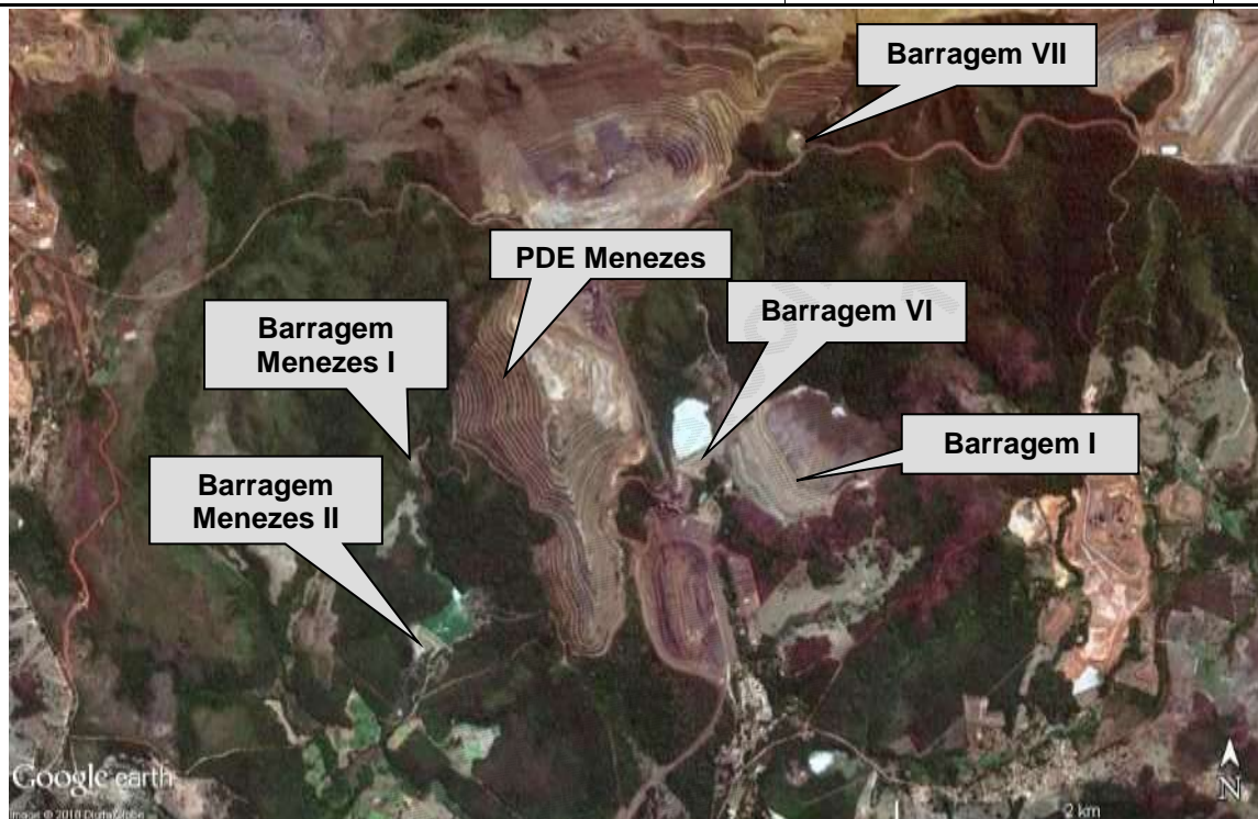
Figura 1 – Vista geral da região do entorno da Barragem I (Fonte: Google Earth - Outubro/2017).
