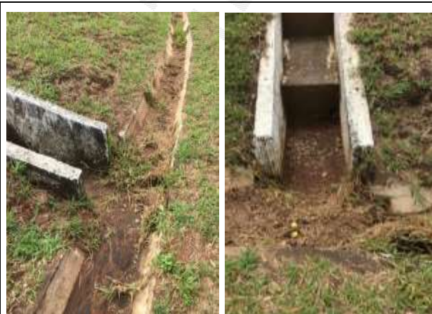
Fotos 5 – Trechos de canaletas de drenagem obstruídos por sedimentos.
