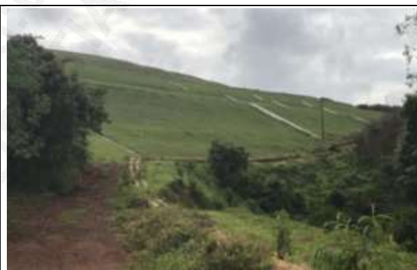
Foto 4 - Vista geral do talude de jusante. Classificação quanto ao EC ("deterioração dos taludes/paramentos"): 0.
