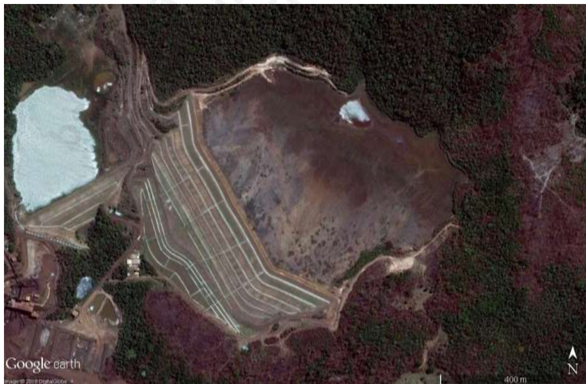
Figura 2 – Vista geral do reservatório da Barragem I (Fonte: Google Earth - Outubro/2017).
