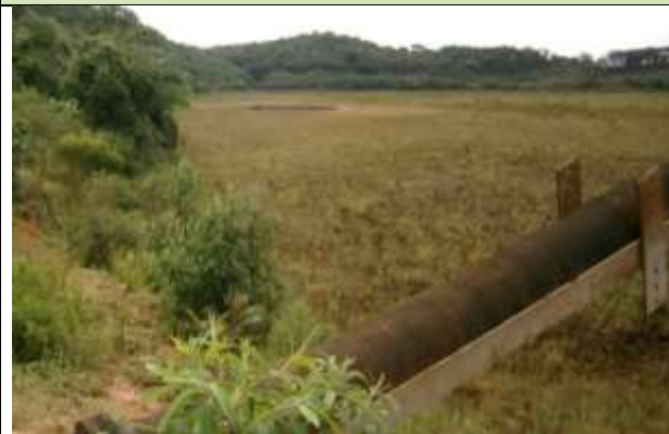
Foto 1 - Vista do reservatório, praticamente seco, com pequena lâmina d'água no trecho montante do reservatório.
